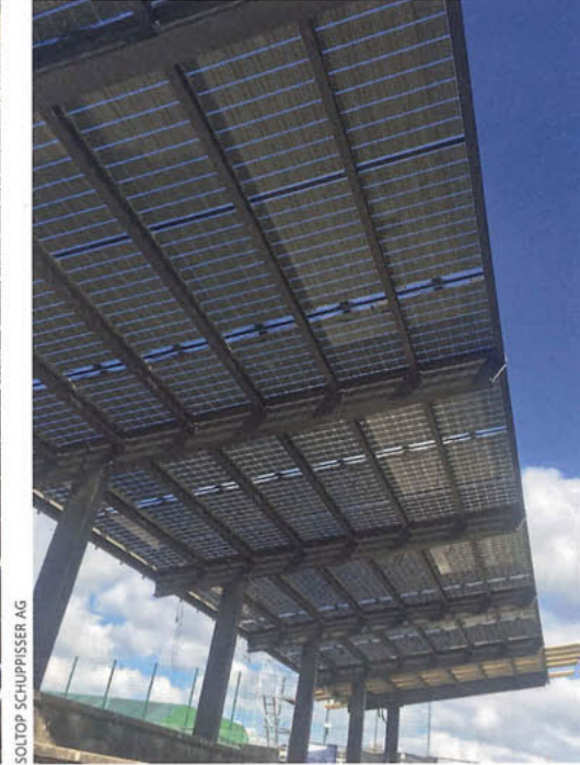
Die Idee für ein Sonnendach wurde von der Stadt Rapperswil-Jona wie auch vom kantonalen Amt für Sport unterstützt. Die für rund 600 Personen konzipierte Tribüne mit 12-Grad-Pulldach ist mit Soltop-Elektra-Crystal-Modulen belegt.
